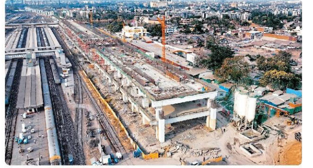
अहमदाबाद का निर्माणाधीन बुलेट ट्रेन स्टेशन।
