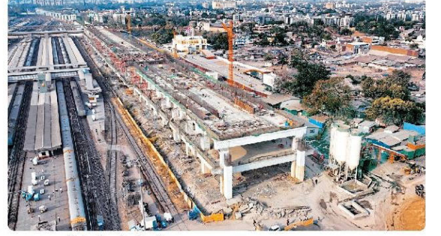
अहमदाबाद का निर्माणाधीन बुलेट ट्रेन स्टेशन।
