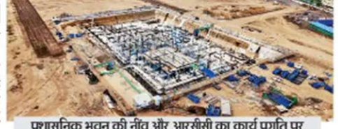
प्रशासनिक भवन की नींव और आरसीसी का कार्य प्रगति पर
